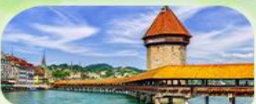
สะพานไมซ์าเปิล
